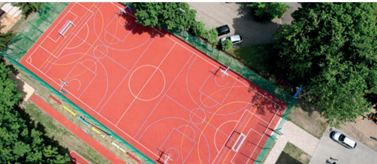
Budowa i przebudowa boiska szkolnego przy SP nr 1
