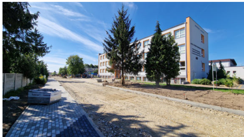
Przebudowa ul. Żeromskiego
