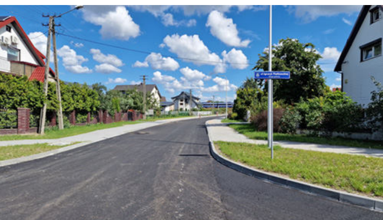
Budowa ul. Piątkowskiej i Sternfelda
