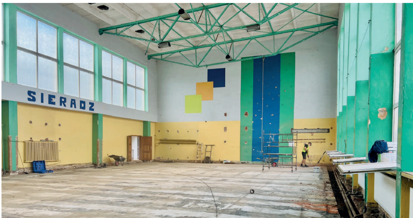
Przebudowa i modernizacja hali sportowej
