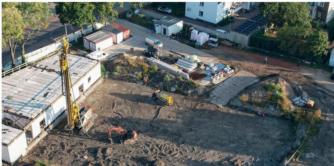
Rozbudowa i modernizacja hali sportowej przy ul. Rycerskiej 4
