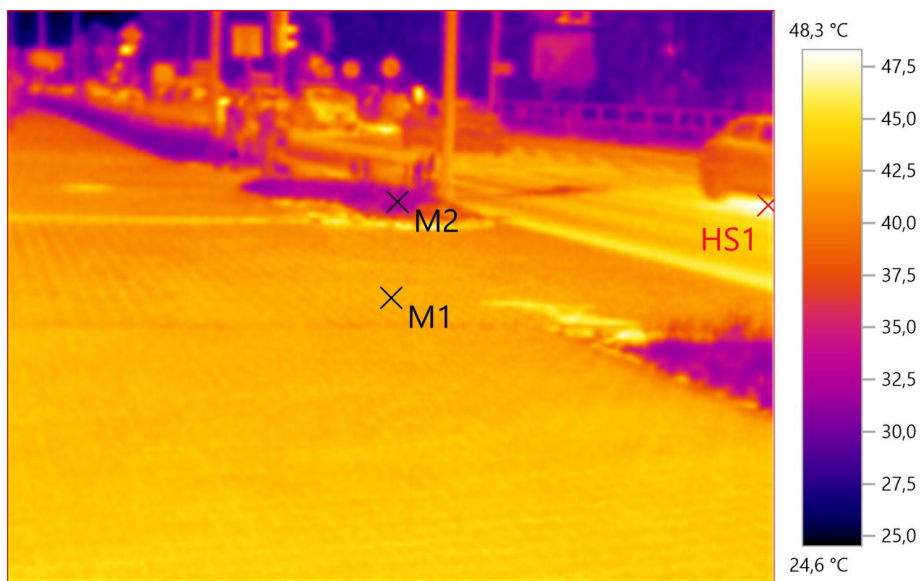
Rysunek 31. Chodnik z kostki betonowej i przyległy pas zieleni wzdłuż drogi — termogram
